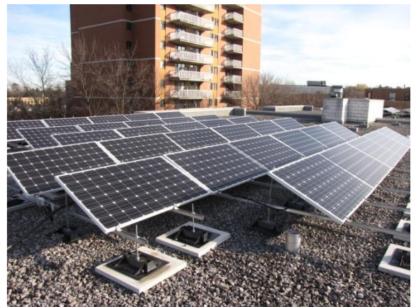
Photo of OCH installation
